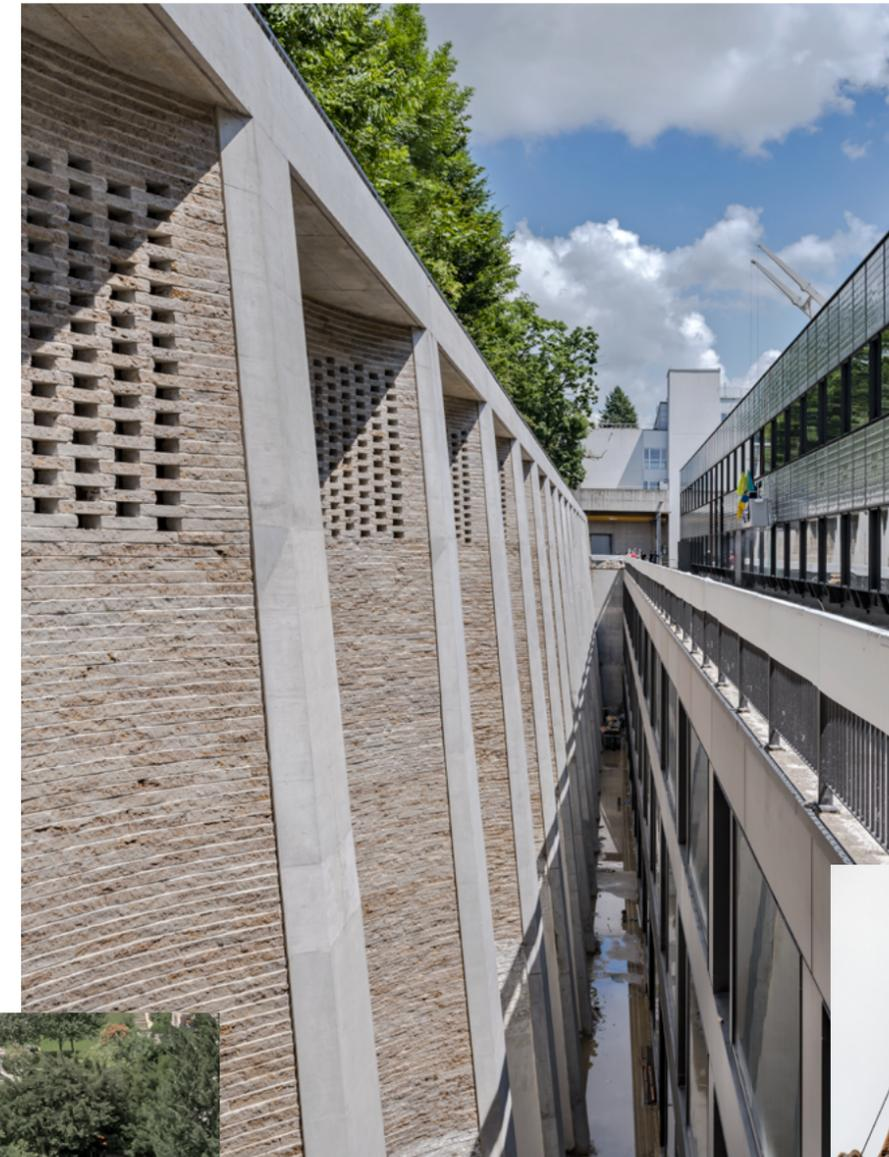
Die Tragstruktur der Stützmauer bildet das vorgespannte Ortbe-tontragwerk. Die mit Naturstein verkleideten, leicht geneigten Bögen bündeln das Licht und führen dieses den unteren Geschossen des Gebäudes zu.
